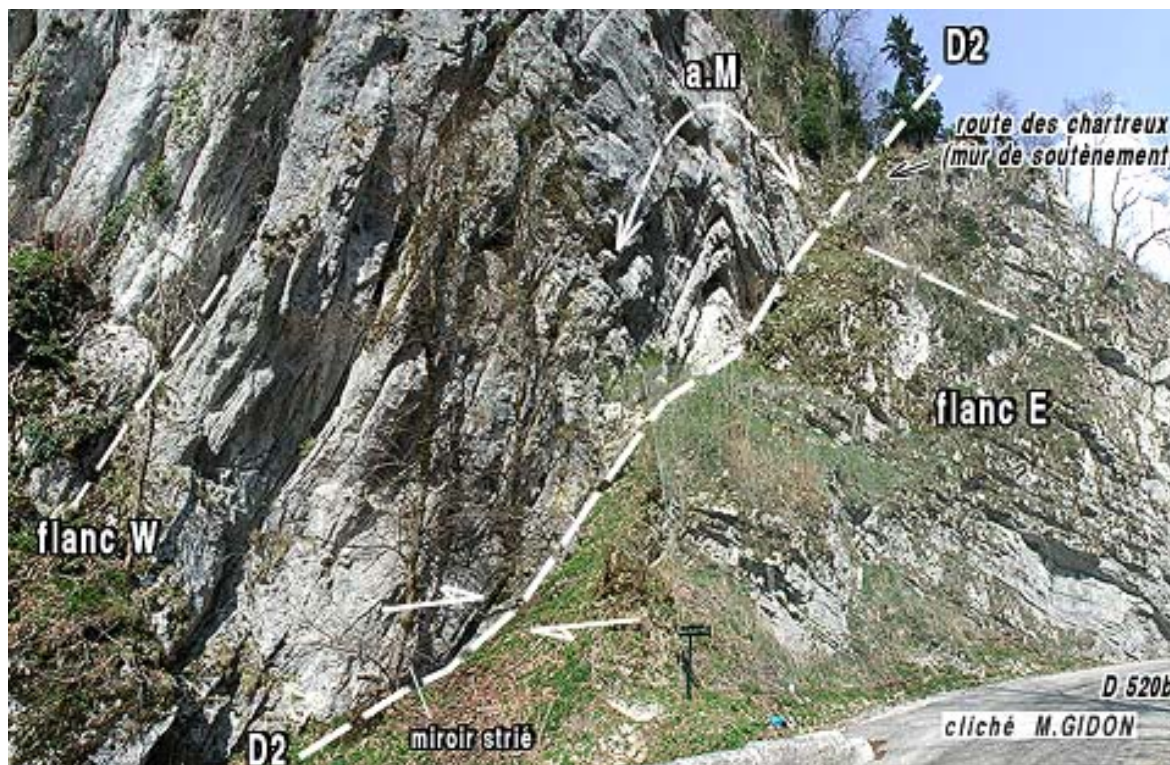
Fig. 10b - Le mur rocheux dominant la D 520b , entre la sortie du second tunnel (à gauche) et le passage sous la galerie de protection (à droite), vu du parapet du pont du Trou de l'Âne, côté Guiers.
